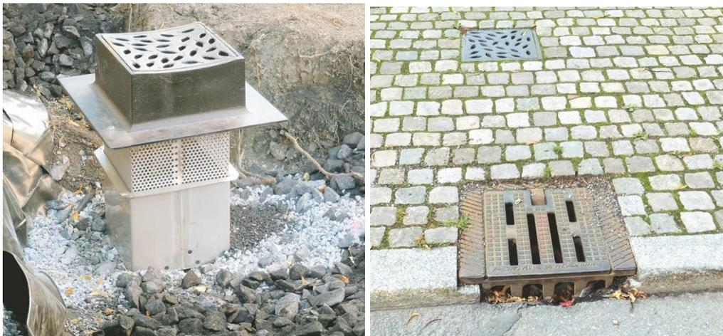
Schacht zur Be- und Entlüftung der Pflanzgrube sowie zur Einleitung von Regenabflüssen, während und nach dem Einbau in eine Pflasterdecke. Foto: C. Biber
